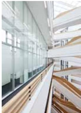
Nachhaltigkeit und eine flexible Nutzung gehörten zu den wichtigsten Anforderungen der Architektur. Flächenbündige Glaswände bringen Licht ins Atrium. Sie erfüllen bauliche Auflagen wie Schall- und Brandschutz und bestehen im Hinblick auf die Zertifizierung aus geprüften Rohstoffen.
